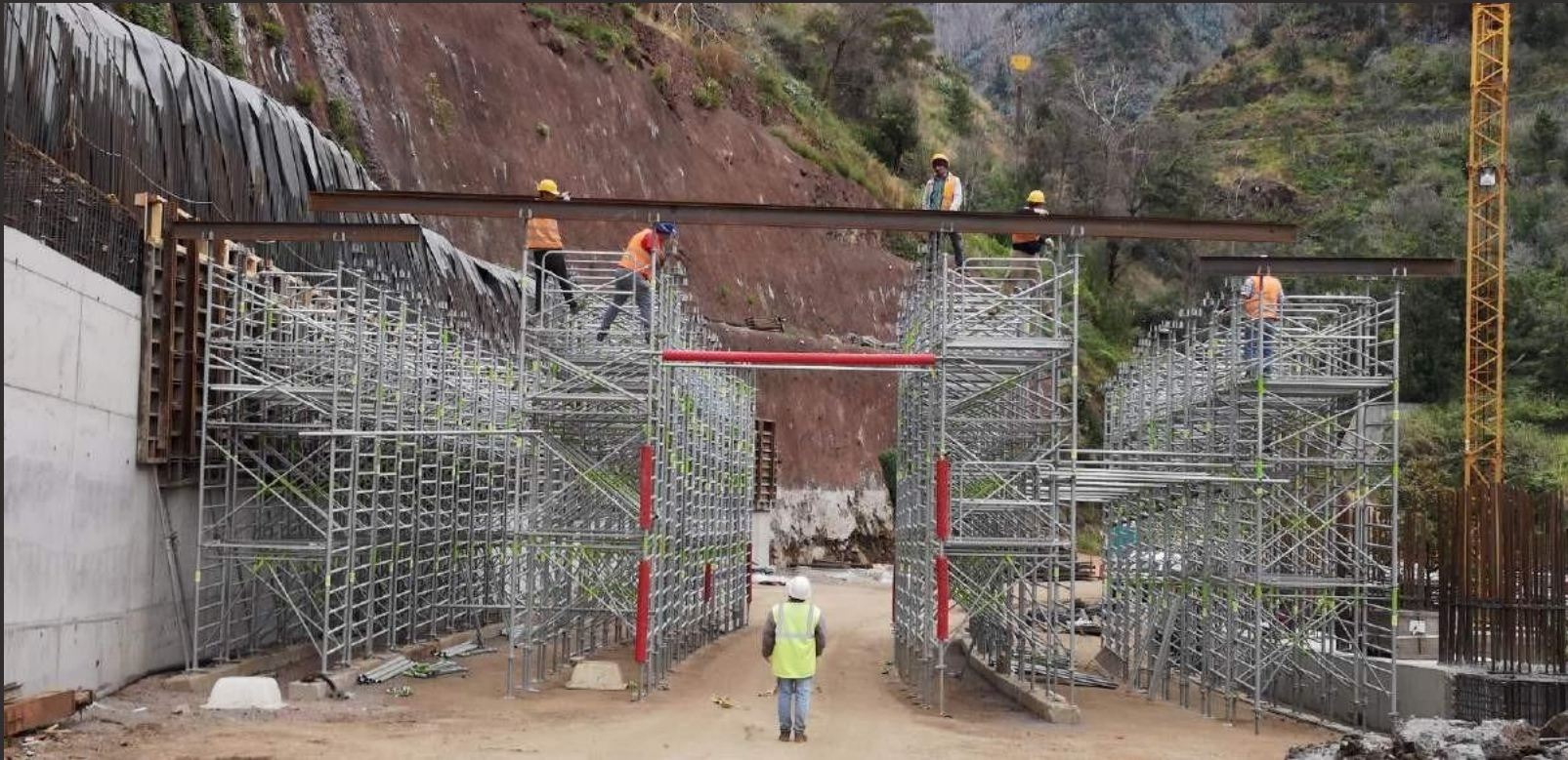
False Tunel, Madeira, PT, TECNOVIA
