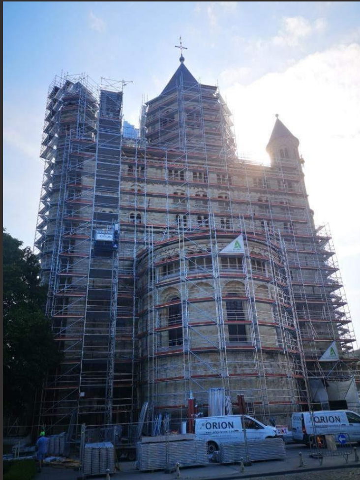
Collegiale de Nivelles, BE, MetalScaff
